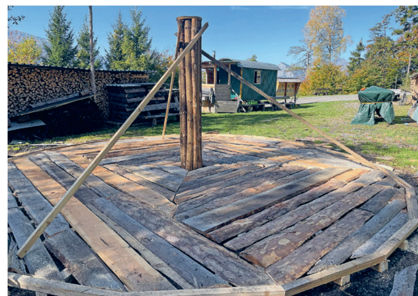
Der Bodenrost ist gelegt.
